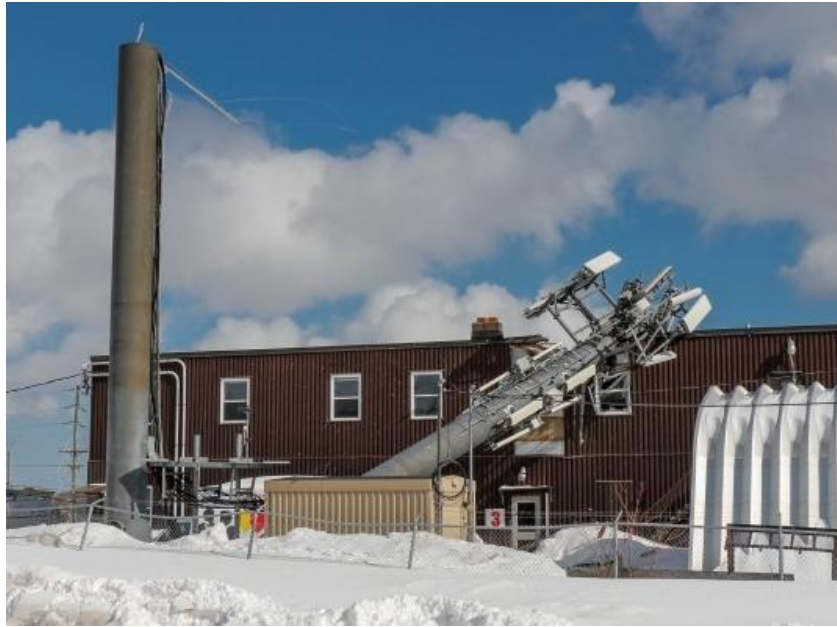
Рис. 1. Загальний вигляд опори, що впала, в Сент-Джонс [6]
