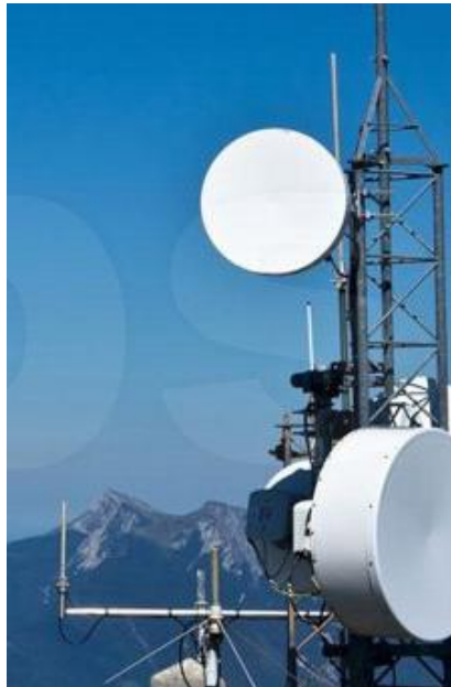
Рис. 2. Розташування радіорелейних антен на вежі мобільного зв'язку [12]
