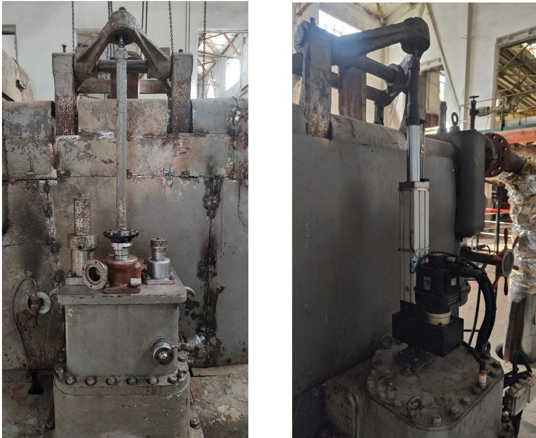
Рис. 2. Гідравліко-механічний блок регулювання (турбіна потужністю 6 МВт (а) та електро-механічний сервопривод (турбіна потужністю 4 МВт (б))
